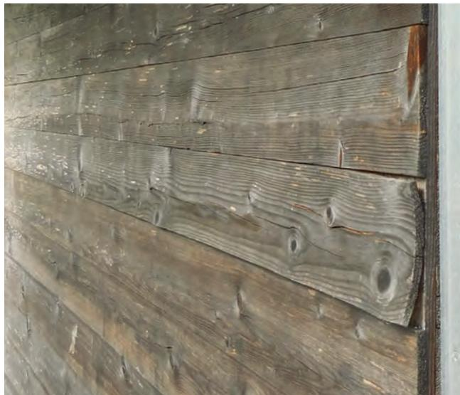
Bei der Nichtbeachtung der Herstellerangaben und bei mangelhafter Wartung und Pflege können Delaminierungen und Beschichtungsschäden auftreten.
