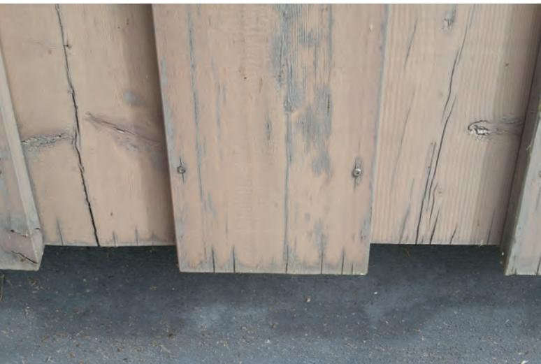
Die Schnittkanten der farbig behandelten Hölzer wurden bei der Montage nicht an den Schnittkanten nachbehandelt und führten deshalb zu stärkeren Endrissen, höherer Feuchtigkeit und zu Verfärbungen unter der Farbbehandlung.
