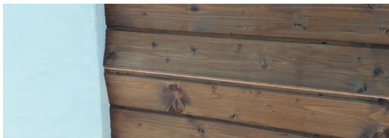
Wenn Fassadenprofile zu trocken eingebaut werden, kann es bei steigender Holzfeuchte zum Werfen der Profile kommen.
