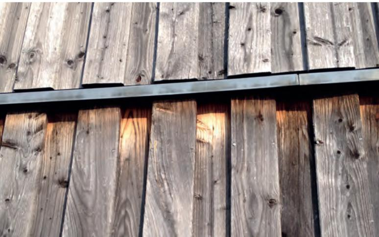
Bei senkrechten und diagonalen Fassadenbekleidungen dürfen i.d.R. keine stumpfen Längsstöße ausgeführt werden.
