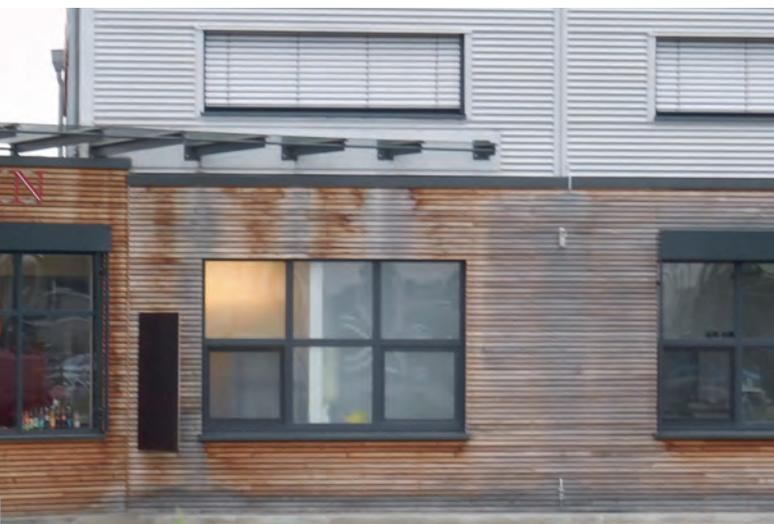
Das Glasvordach wurde nicht optimal ausgeführt, und Wasser läuft an den Trägern auf die Holzfassade. Das Holz wäscht aus, da UV-Licht nicht vom Glas abgehalten wird.
