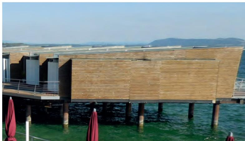
Bei diesem Objekt ist die farbig behandelte Holzfassade auf der Wasserseite nur mit sehr großem Aufwand regelmäßig zu kontrollieren bzw. zu warten und Instand zu setzen. Alternativ sollten pflegeleichtere Produkte eingesetzt werden.
