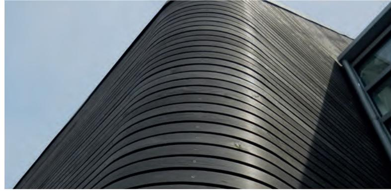
Vieles ist möglich, jedoch kommt Holz bei bestimmten Rundungen an seine Grenzen. HPL- oder Metallplatten sind für solche Konstruktionen besser geeignet
