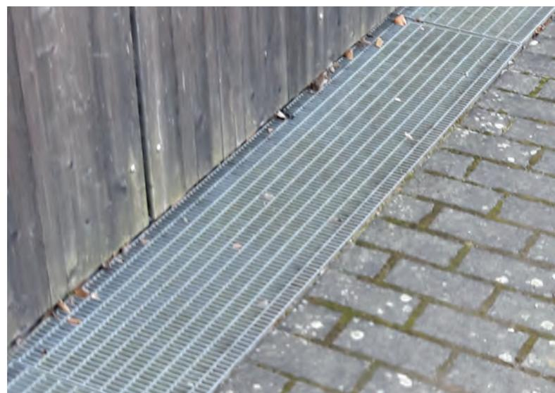
Mit ca. 200 mm breiten Gitterrosten kann eine nicht ganz optimale Sonderlösung erzielt werden.
