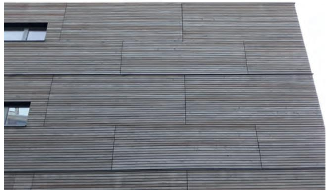
Die Fassade bei diesem mehrgeschossigen Objekt wurde mit farbig behandelten Holzprofilen in Elementbauweise erstellt. Die Elemente wurden in der Werkstatt vorgefertigt. Dadurch konnte die Bauzeit verkürzt werden.
