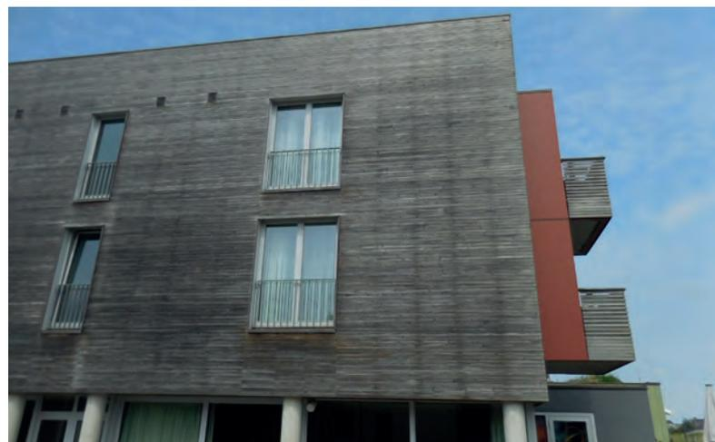
Wenn standortbedingt mit einer Aufweitung der Trag- und Grundlattung zu rechnen ist, muss eine Holzart verwendet werden, die min. in der Gebrauchsklasse GK 3.1 eingesetzt werden darf.
