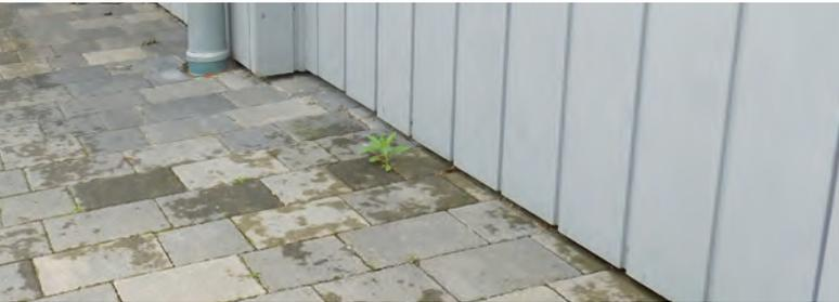
Die Pflasterung wurde bis an die Fassadenbekleidung aus Holz hochgezogen. Dadurch ist mit einer kürzeren Nutzungsdauer der Fassade zu rechnen.
