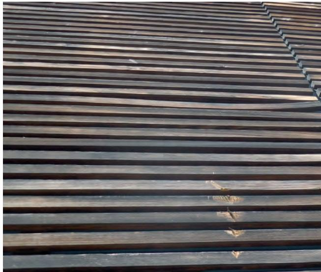
Zu große Abstände bei der Unterkonstruktion oder zu hohe Feuchtigkeit führt bei drehwüchsigen Hölzern zu Ausfällen.
