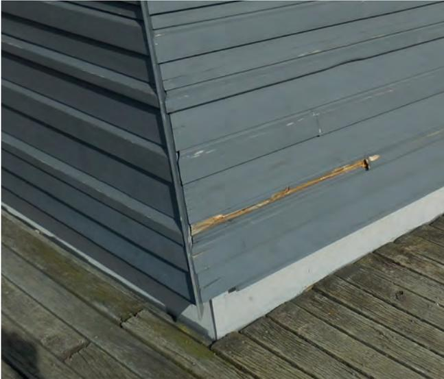
Nach ca. 11 Jahren führte der geringe Spritzwasserabstand bei diesem Objekt zu einem vorzeitigen Ausfall einiger Profile.
