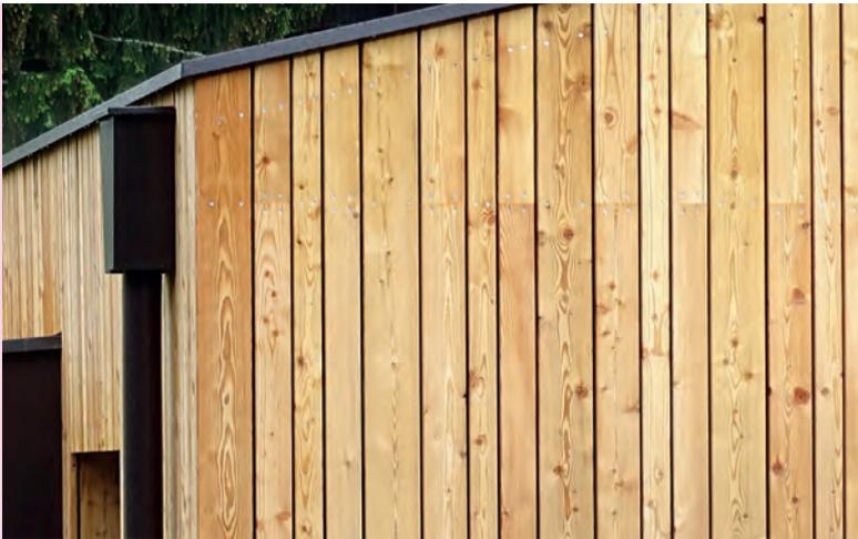
Bei senkrechten und diagonalen Fassadenverkleidungen dürfen i.d.R. keine stumpfen Längsstöße ausgeführt werden.
