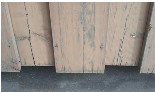
Die Schnittkanten müssen bei behandelten Fassadenprofilen mindestens 1-mal versiegelt werden, damit es nicht zu einer Unterwanderung der Beschichtung durch Feuchtigkeit kommt.
