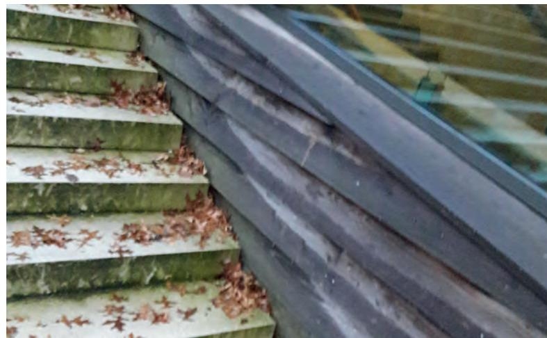
Zu geringe Spritzwasserabstände und Ablagerungen von Schutz oder Laub, führen zu einem vorzeitigen Ausfall der Konstruktion.
