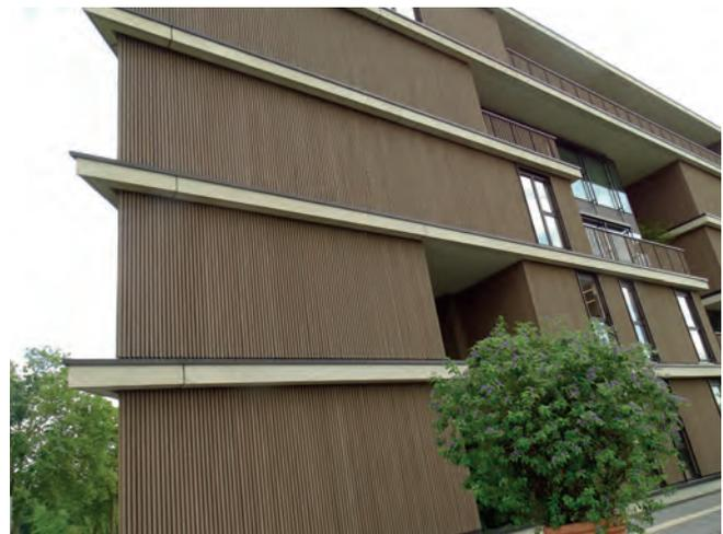
Alternativ können die Betondecken vorspringen und den Brandschutz sicherstellen. Auch durch diese Konstruktion werden nur kürzere Längen benötigt.
