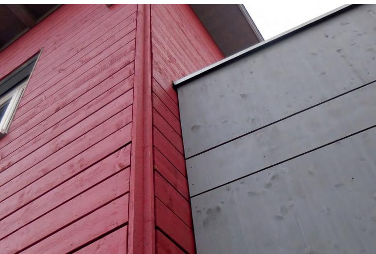
Bei der Gestaltung von Fassaden können Massivholzprofile und Platten sehr gut kombiniert werden. Auch unterschiedliche Farben werden für die Gestaltung gewählt.
