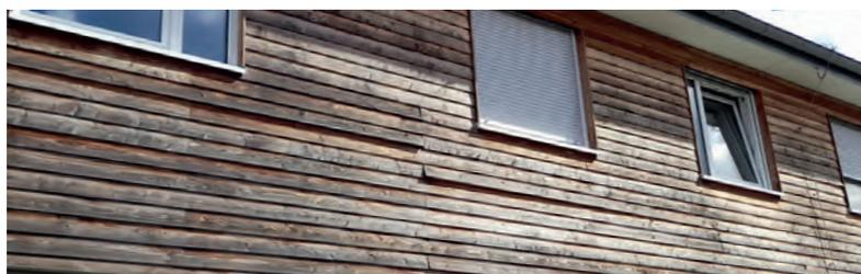
Bei zu hoher Holzfeuchte springen Fassadenprofile bei niedriger Holzfeuchte aus der Nut.
