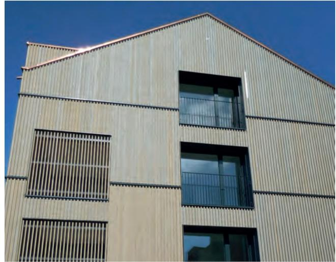
Mit Metallprofilen können bei Fassadenbekleidungen evtl. Längenprobleme gelöst werden und zusätzlich notwendige Brandsperren eingebaut werden.
