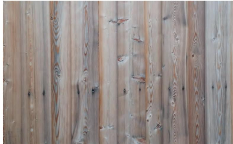
Bei der Verwendung von martensitischen Schrauben kann es durch die Inhaltstoffe auch bei einer Lärche zu einer Reaktion mit den Schrauben kommen.
