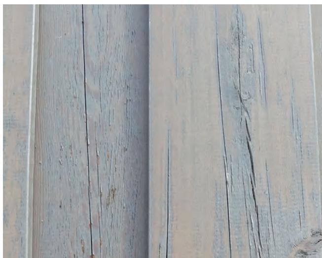
Bei der Montage kann aufgrund von Drehwuchs eine weitere Sortierung und Auskappung notwendig werden.
