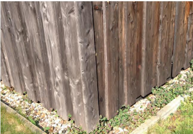
Bewuchs im Kiesstreifen muss entfernt werden, damit der Spritzwasserschutz sichergestellt wird.
