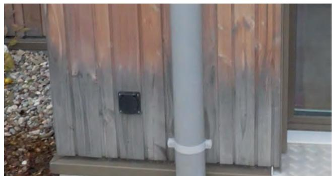
Der zu geringe Spritzwasserabstand führte bei dieser Holzfassade zu einer ungleichmäßigen Vergrauung.
