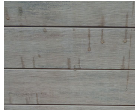
Fleckenbildung durch von Regen angelöste Partikel
