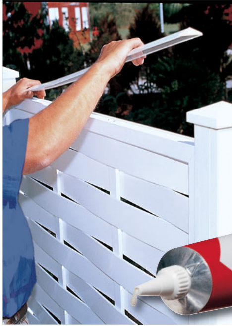
Kleber (0783) zur Befestigung der Aufsatzleisten und Kappen.
