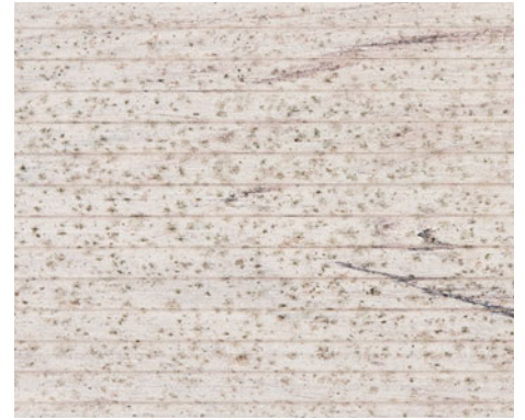
Stockflecken/Schimmel auf der Oberfläche
