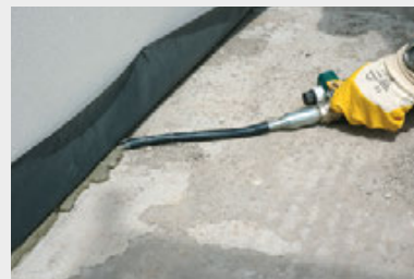
Maschinelles Verfüllen der Bauteilfuge
