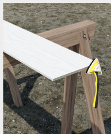
Auftragen der ColourPlus™ Kantenversiegelung vor der Montage.
