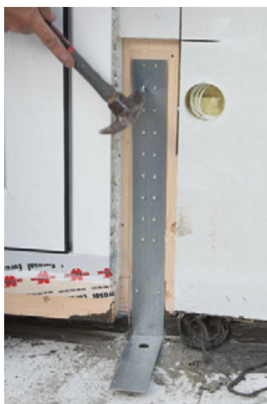
Montage Zuganker (Verdübelung Lastplatte noch nicht erfolgt)
