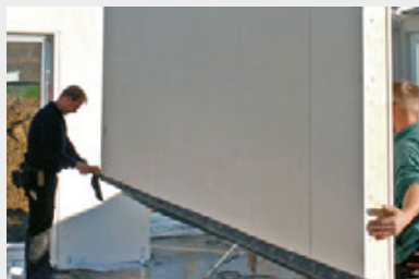
Positionieren, Ausrichten und Unterklotzen der Wandelemente
