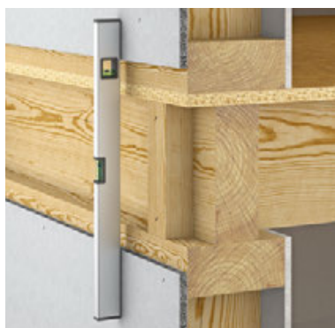
Bild 1: Ausrichten der Wandelemente
