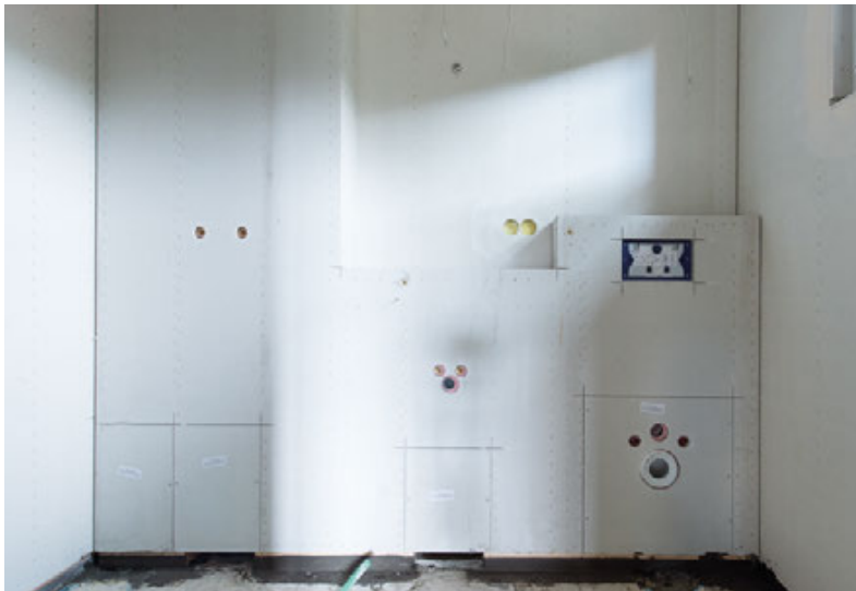
Tragständer für wandhängende WCs mit Einbauspülkästen
