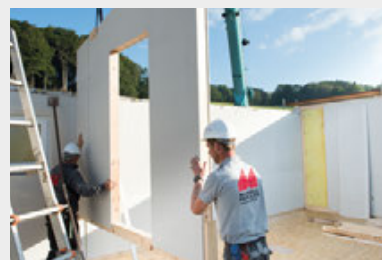
Montage auf der Baustelle
