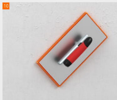
Abfilzen der Putzoberfläche mit einer Schwamm-scheibe
