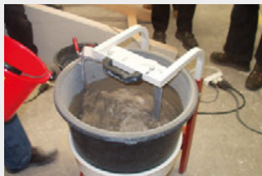
Anmischen fermacell™ Quellmörtel
