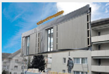
Krantransport auf der Baustelle
