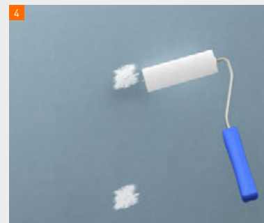
Deckendes Abtupfen der Verbindungsmittel in der Plattenfläche
