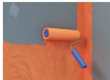
Abb. 6: Sicherstellung der Abdichtung für die Wasser-einwirkungsklassen W1-I und W2-I. fermacell™ Flüssigfolie mit der Rolle mind. 2 x vollflächig auftragen (Trockenschichtdicke mindestens 0,5 mm). Gemäß DIN 18534-3 wird für den 2. Auftrag ein Farbunterschied zur besseren Nachvollziehbarkeit gefordert. 1. Auftrag: fermacell™ Flüssigfolie in Originalfarbe satt auftragen und trocknen lassen
