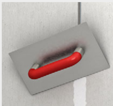
Spachteln von Fugen, entscheidend für Oberflächenqualitäten Q1 bis Q4
