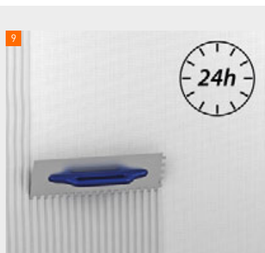
Aufbringen der zweiten Putzschicht 2–3 mm fermacell™ HD Leichtmörtel nach Erhärten der Armierungsschicht (Variante A)
