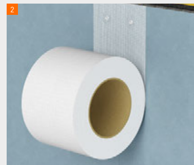
Aufbringen des fermacell™ Armierungsbandes HD
