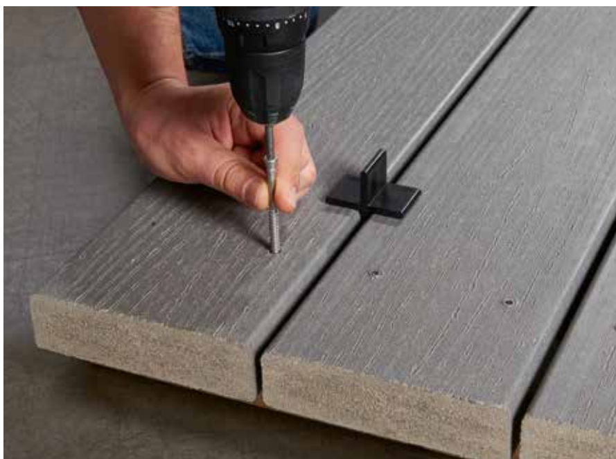
Verschraubung der Tragbohle
