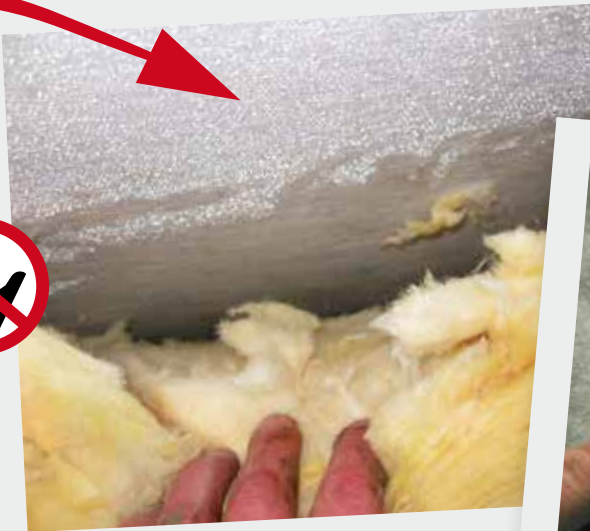
Mikroporöse Bahn: Kein aktiver Feuchtetransport > nasse Konstruktion
