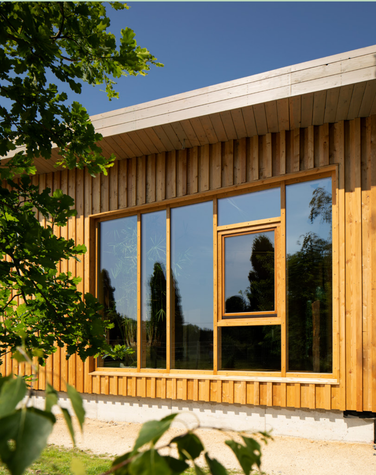
Boden-Deckelschalung sib. Lärche, unbehandelt
