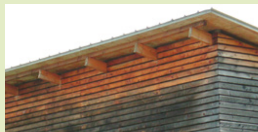
Unbehandelte Lärche witterungsbedingt verschieden vergraut (unter Dachüberstand und auf freier Fassadenfläche)
